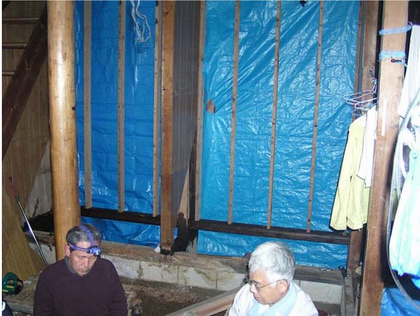
北壁骨組み設置後(10月10日)
