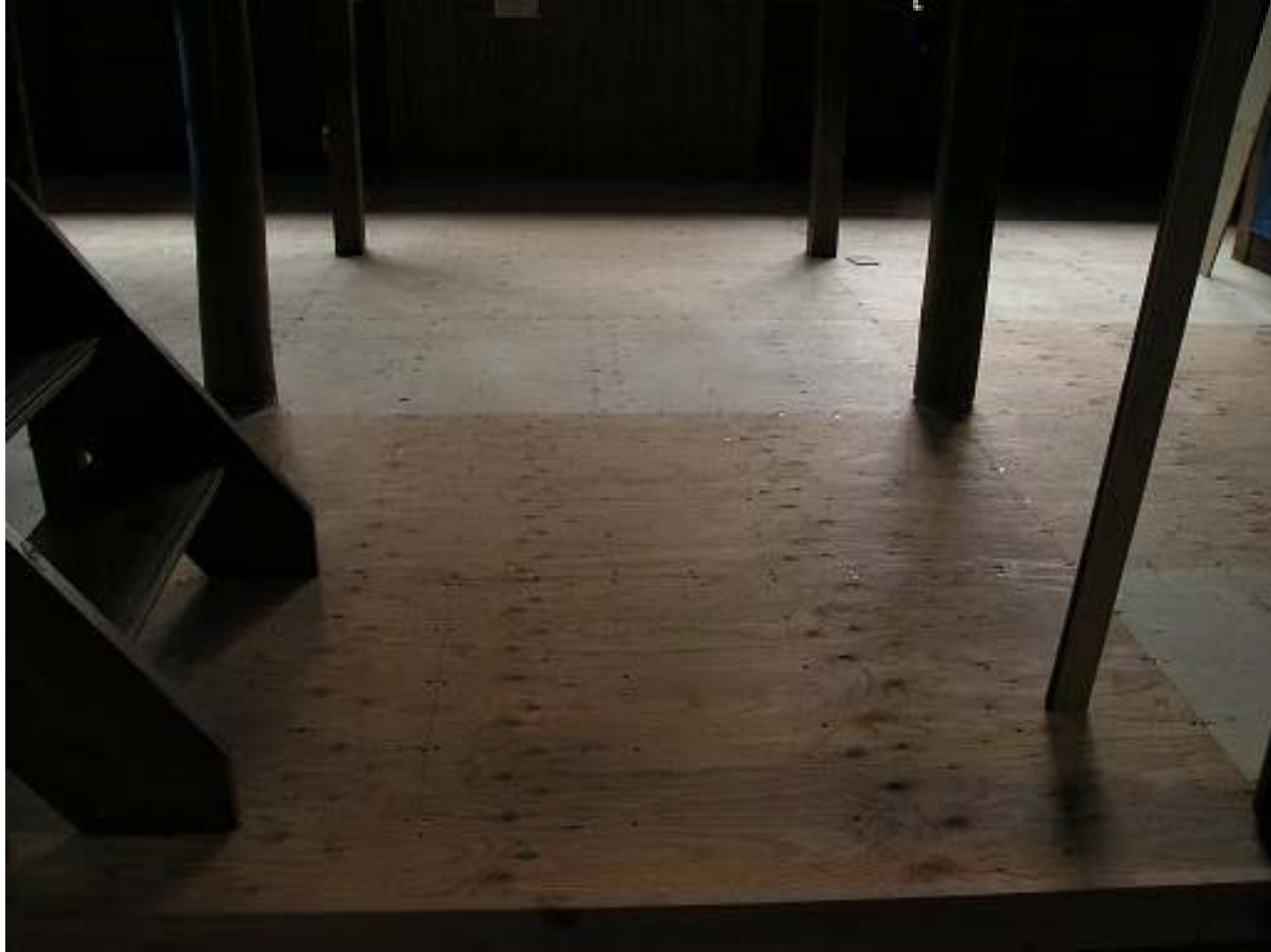
小屋内部 構造用合板張り後
