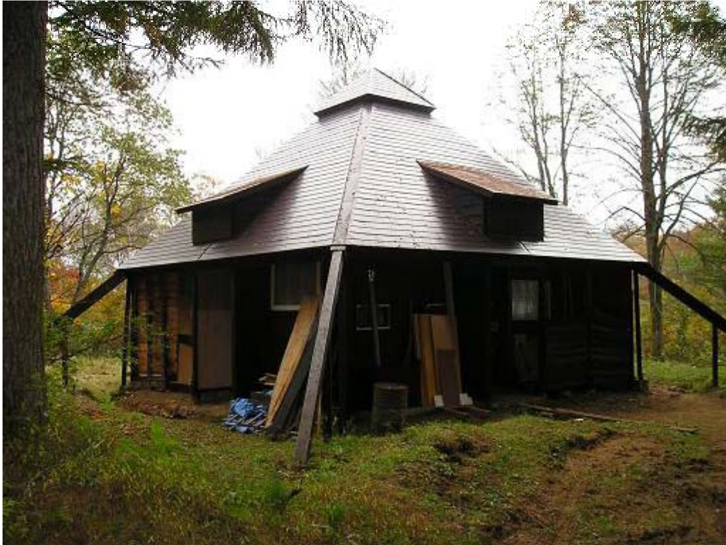
現在の小屋外観
