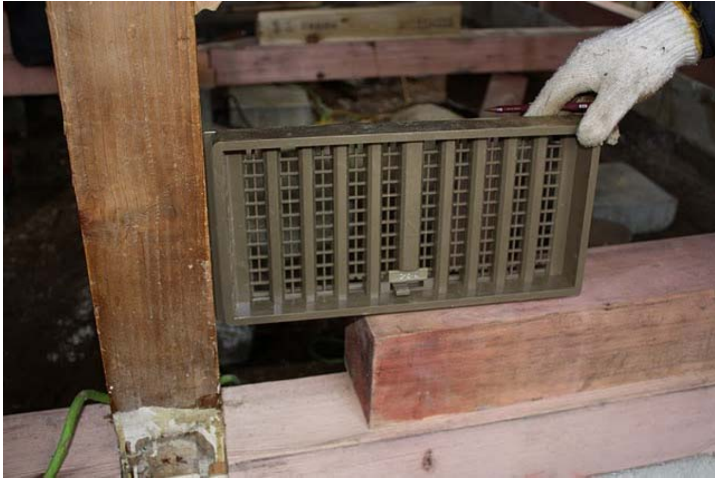
基礎ブロックに入れる通気口
