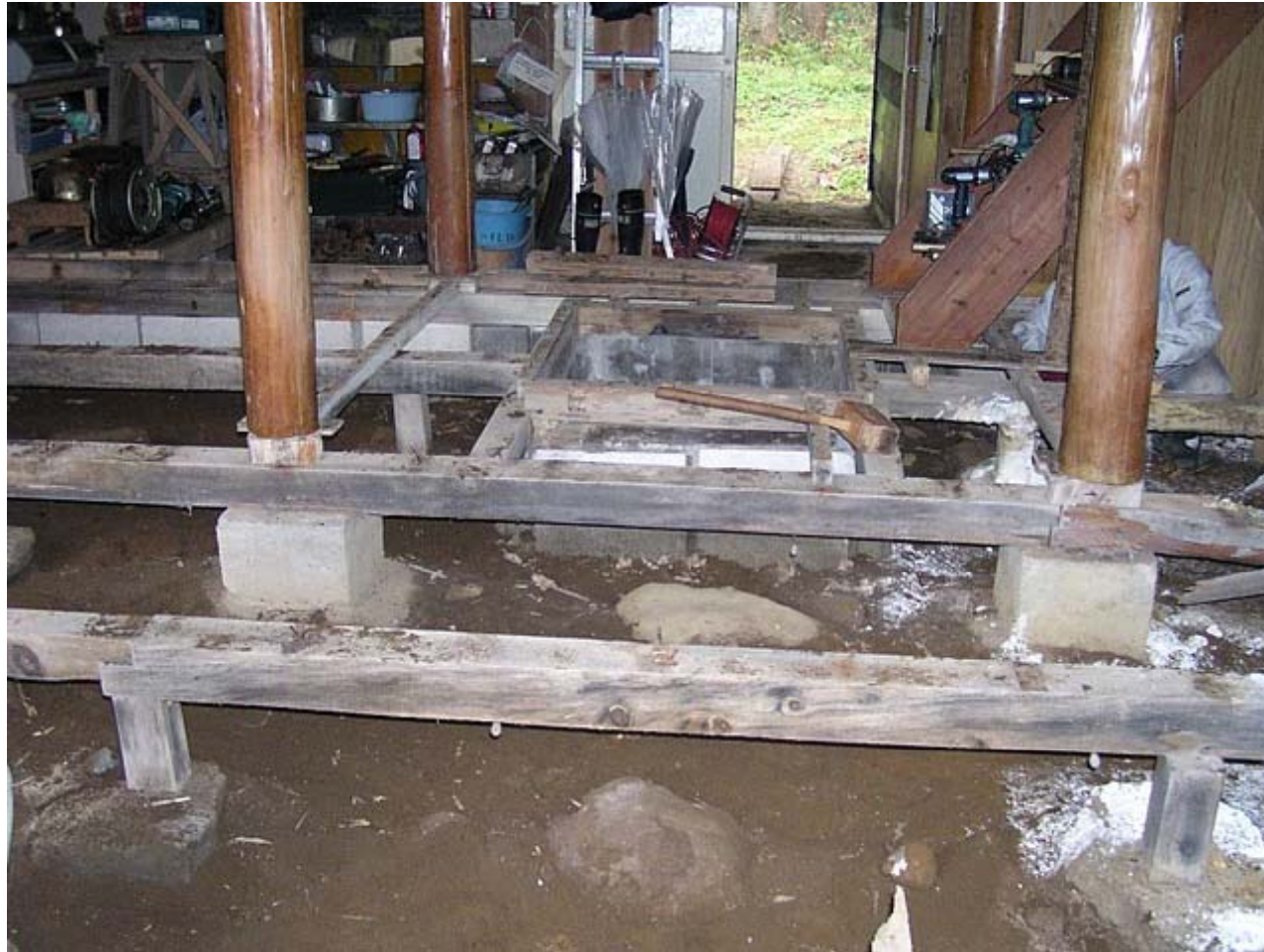
床解体完了(10月11日)
