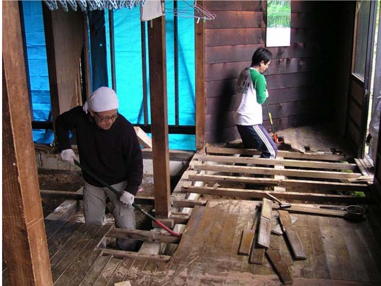
床解体作業(10月11日)
