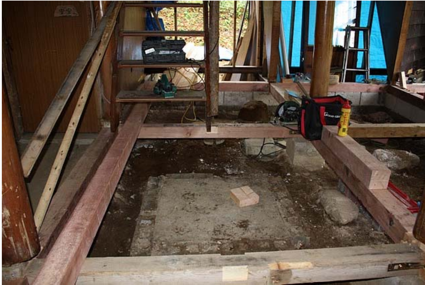
コタツ部分ブロック解体後
